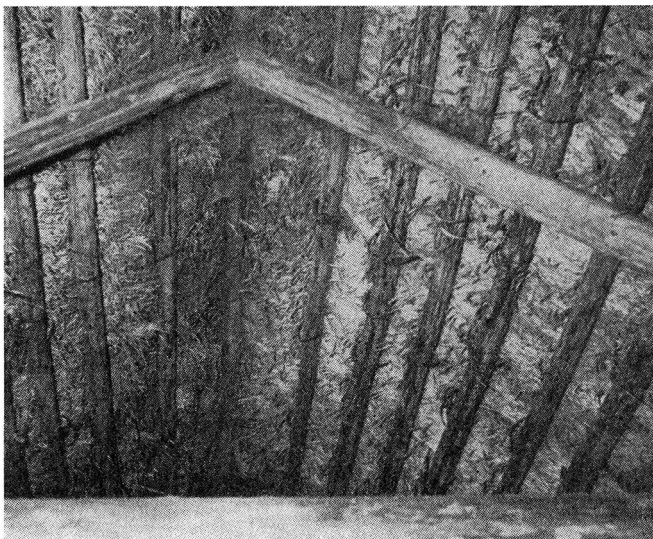
8. Insidan av halmtak. Man ser vidjebanden. Ögärdet, Liared sn. Redvägs hd. Foto I. Vallin.
