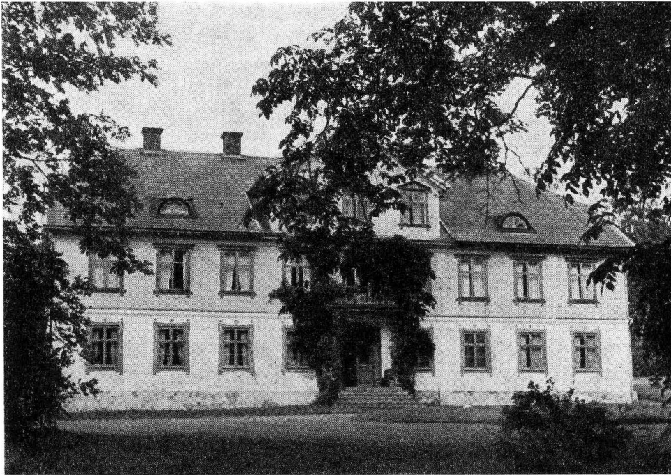
”Stora byggningen” såg emellertid ut precis som på vår tid med undervåningens metertjocka stenväggar vitrappade och det övre träverket ljust gråmålat.
