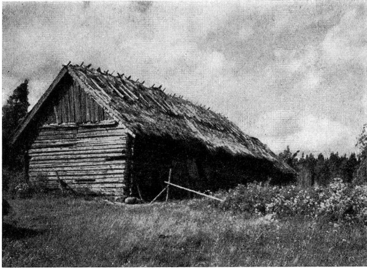
7. Halmtäckt ladugård med långa pällträ. Ögärdet, Liared sn, Redvägs hd. Foto I. Vallin.
