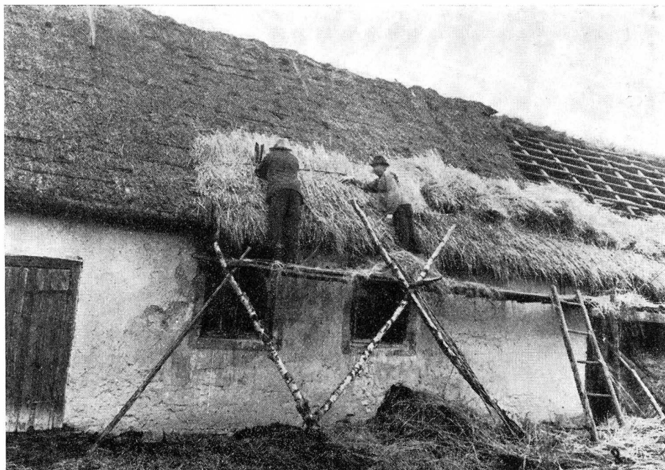
2. Halmtak under omläggning. Till höger nytt tak, till vänster skoning (halvsulning). Man ser ställningen och stegen. Vilske hd. Gökhem sn. Foto Nord. museet.
