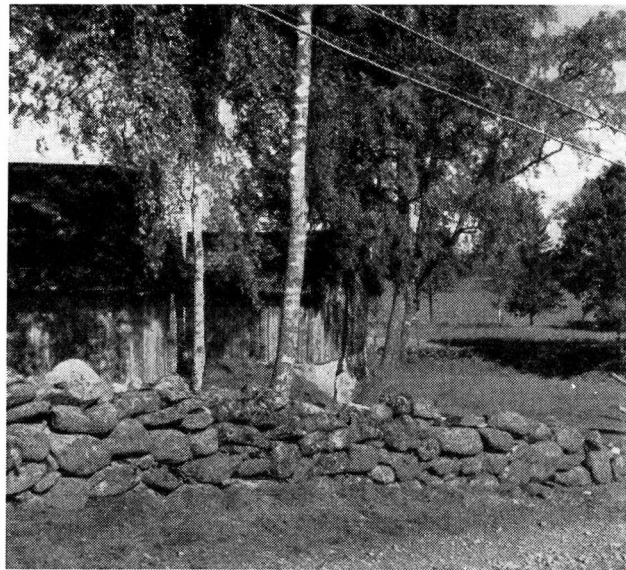
Till Hällingsjö gästgivaregård hör många byggnader. Ett par små källare ligger ett stycke ifrån de övriga husen.
