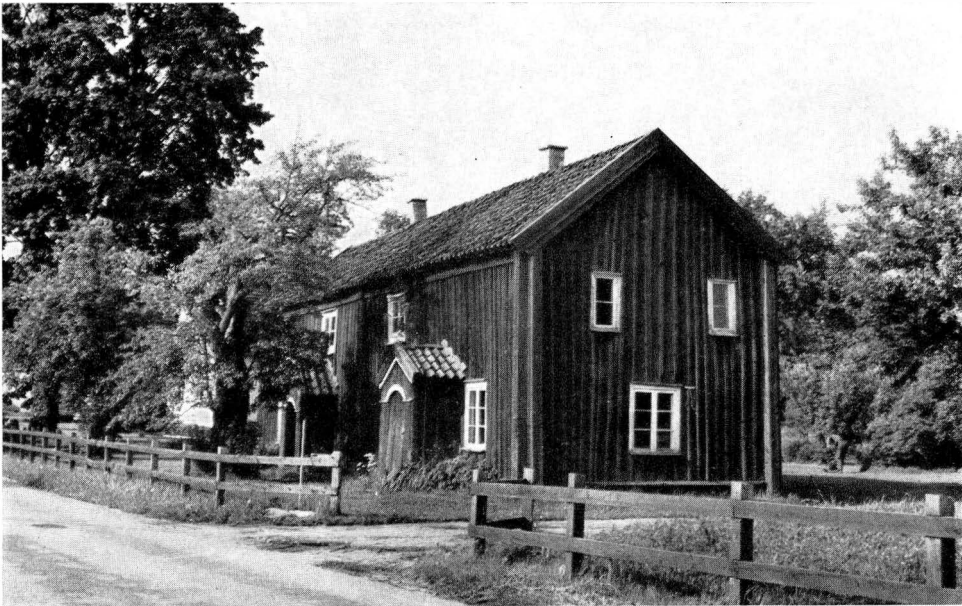
5. Husets södra gavel och västra långsida, sedda mot nordöst.
