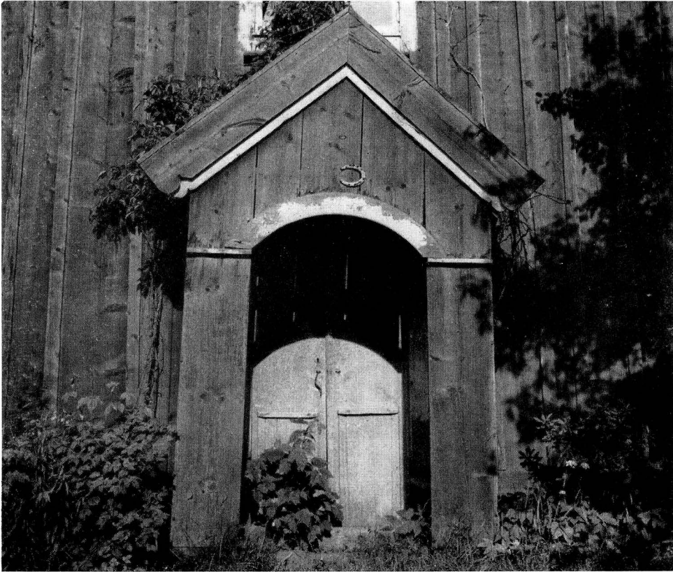
6. Västra långsidans nordliga ingång.
