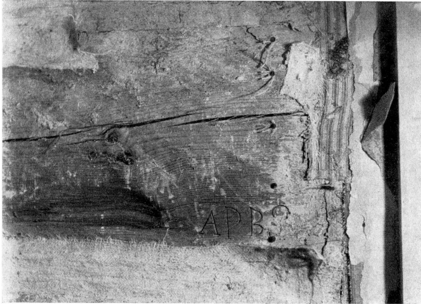
Detalj av yttreväggs konstruktion med diverse tätningsmaterial och inskurna initialer. (Foto förf.)
