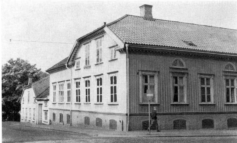
Fasaderna mot Österlånggatan och Kvarngatan.
