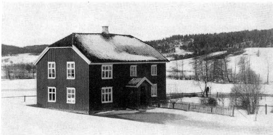
Fasta skolan i Bollebygd, uppförd 1848. Foto 1915, men huset har föga förändrats sedan 1850-talet.
