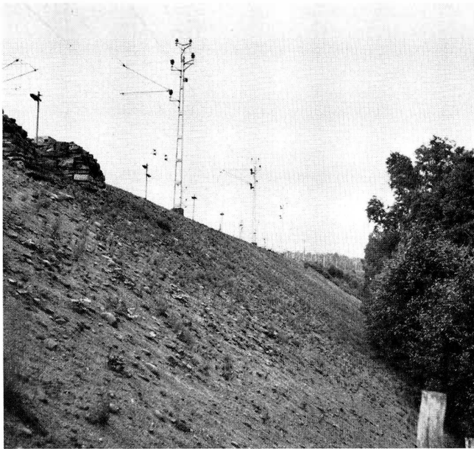
Järnvägsbanken strax norr om Fåglaviks station. Banvallen mäter nära 15 meter i höjd.
