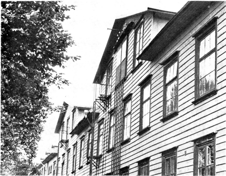
Del av fasaden till gamla fabriken.
