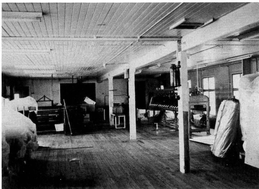
Pelle Vävare AB, Kinnahult. Ovan: fabriksbyggnaden. Nedan: interiör från andra vån. Foto A. Hansson 1973. T.h. Plan och fasader. Uppmätning 1973 av M. Persson, A. Hansson.
