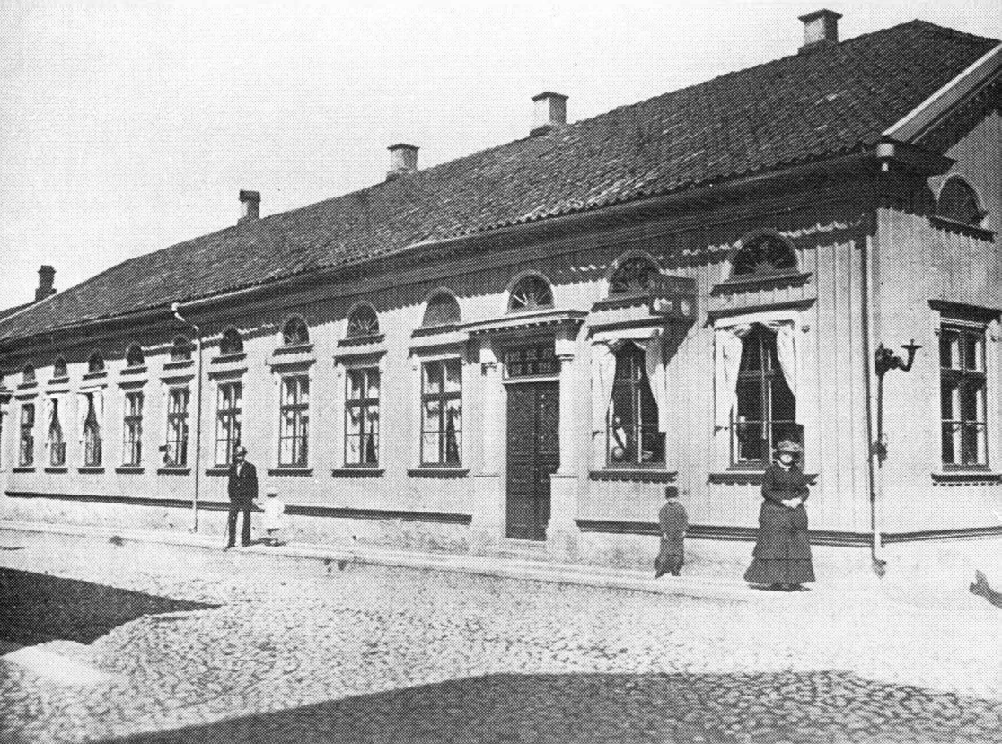
Tidbladskanalen i Kv. Mars, nuvarande St. Brogatan 11—13. En typisk produkt av 1830 års byggnadsordning för Borås.
