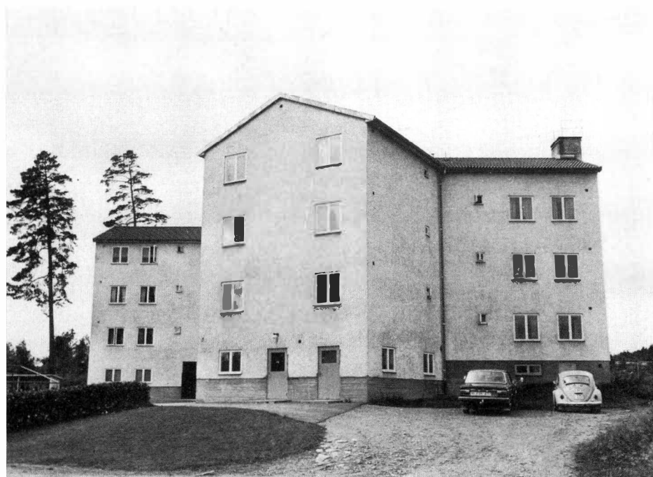
"Stjärnhuset". På 1950-talet planerade bolaget bygga fler sådana hyreshus samtidigt som de gamla arbetarbostäderna skulle rivas. Foto 1973.
