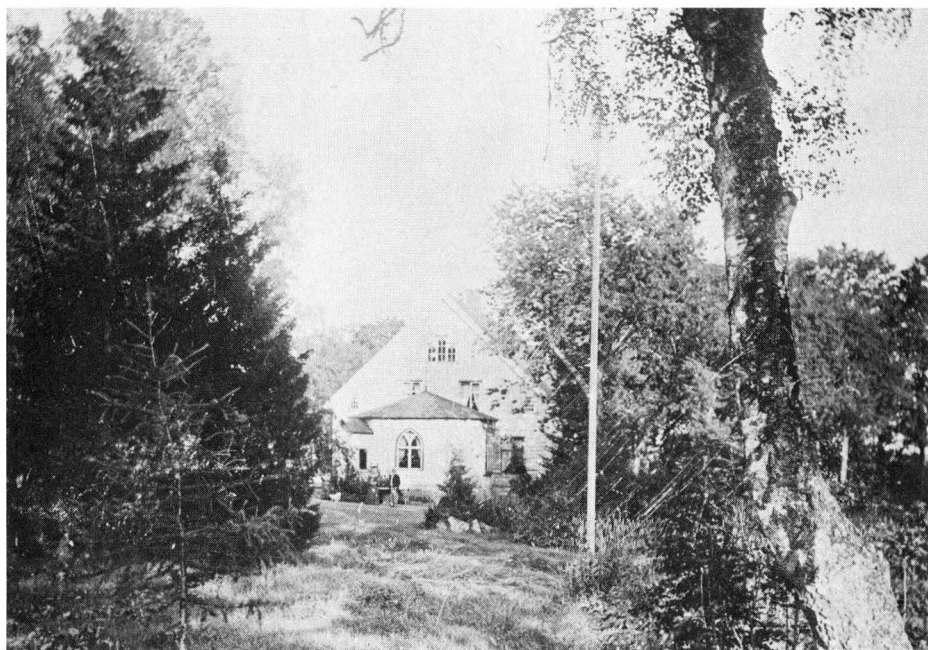
Kølingsholm från väster med tillbyggd biljardsal.
