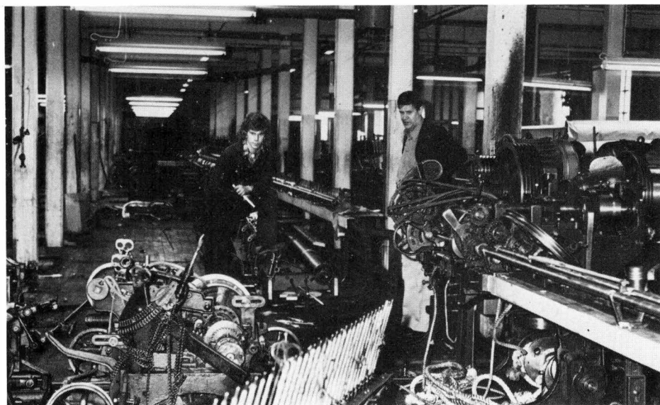
Nedmontering av selfaktor för bomullsspinning. AB Eiser, Borås år 1975.
