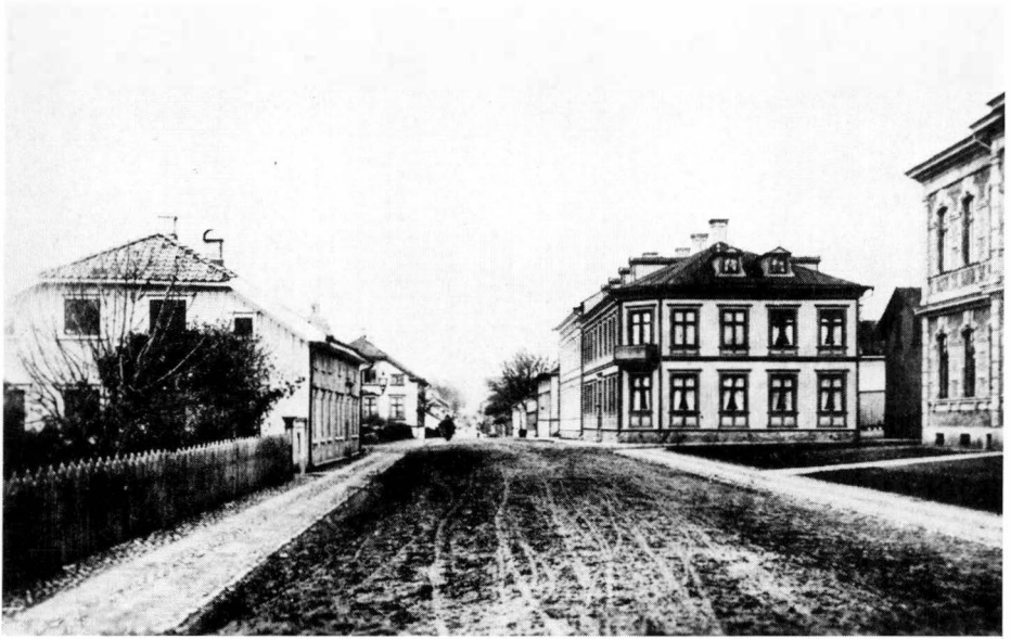
I Österlånggatan 68 (Olssonska gården — senare museibygnad i Ramnaparken) låg Lidéns färgeri (närmast på vänstra sidan) BMR.
