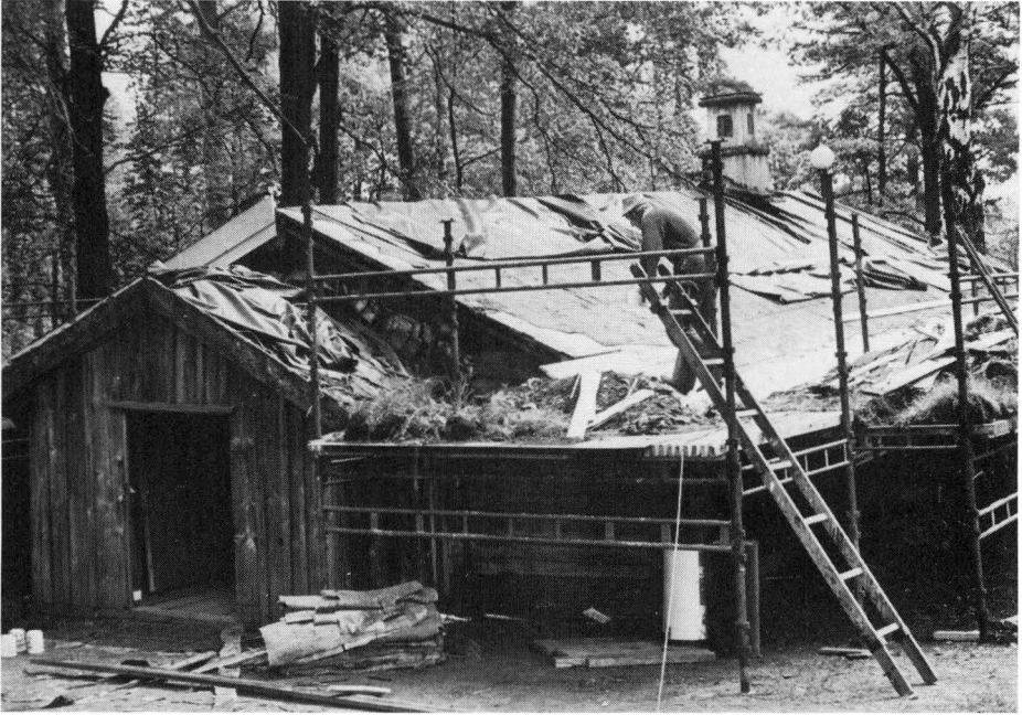
Under 1984 inleddes en första etapp av renoveringsarbeten på fastigheterna i Ramnaparken. På bilden takomläggning på Sockenstugan.
