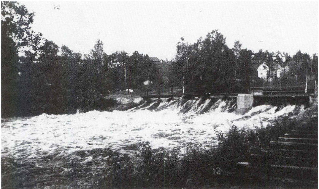
Kinnaström med Lilla bron och "hon" till Kinnaströms Fabriks kraftstation. I bakgrunden Harry Paulssons Speceriaffär sedermera Konsum. Obs. "Skrålen" vid vänster brofäste (avstjälningsplats).
