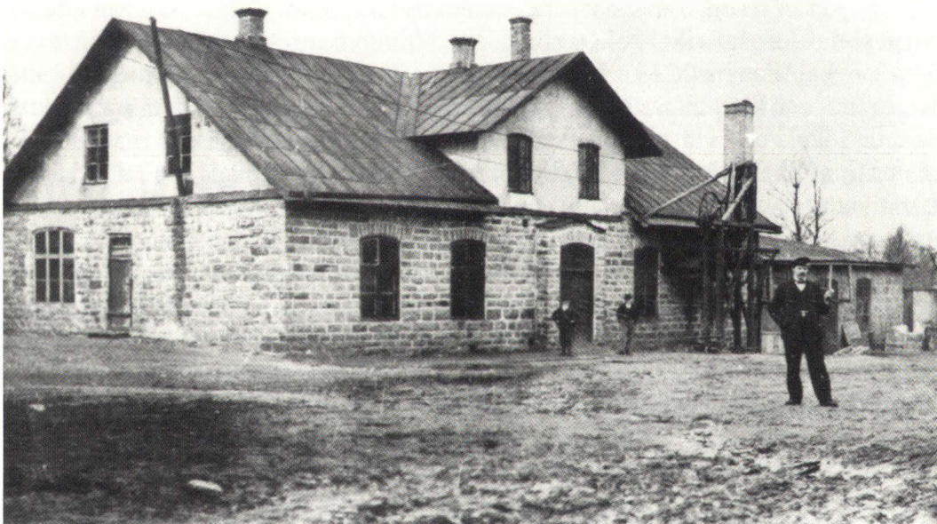
Fig 6. Fabriken vid sekelskiftet. På norrgaveln (till höger) skymtar den första tillbyggnaden, som blev gjuteriet med egen skorsten. Framför den syns de hjul som drev maskinerna. Från ett vattenfall ca 100 m nedströms i ån Nossan överfördes kraften till hjulen medelst linorna som syns i takhöjd. Ställinorna drevs av skovelhjulet i vattenfallet. Det fanns ett särskilt linverk som överförde kraften från ett vattenfall ca 75 m uppströms till verkstaden.
