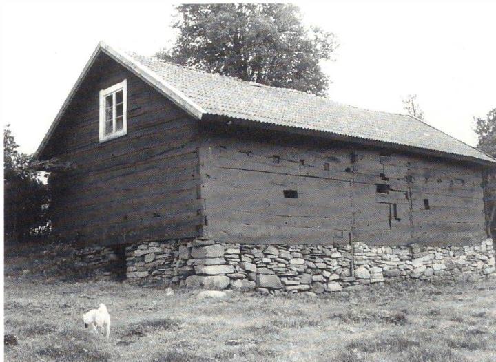
Fig 6. Flygelbyggnad av ek-timmer på sätesgården Simonstorp i Grolanda socken. Har tjänstgjort som magasin och är säkert av hög ålder, uppsatt på kallmur (= utan mur-bruk). Foto förf.
