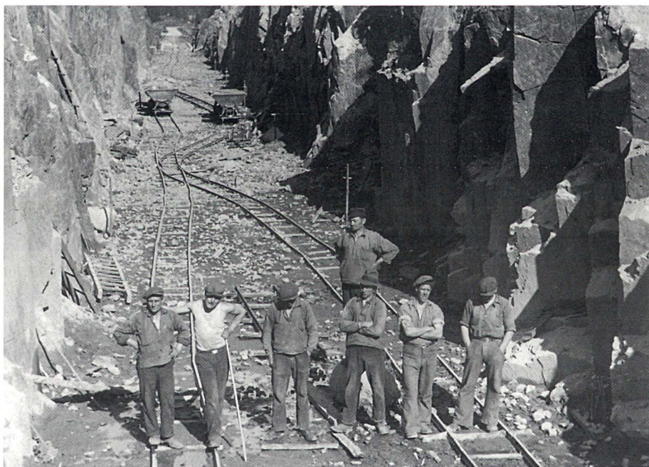
Jönköpingsbanan ca 1930 - De största skärningsarbetena utfördes vid Torbult.
