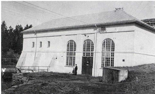
Den gamla kraftstationen i Rydal, byggd 1916. Foto-graferad 1920-talets första hälft. Foto: Sven Hulebäck
