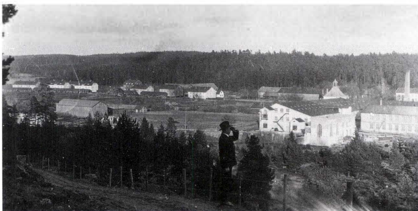
Fabriken från sydväst ca 1927. Den nya kraftstationen under ombyggnad. Foto: Sven Hulebäck
