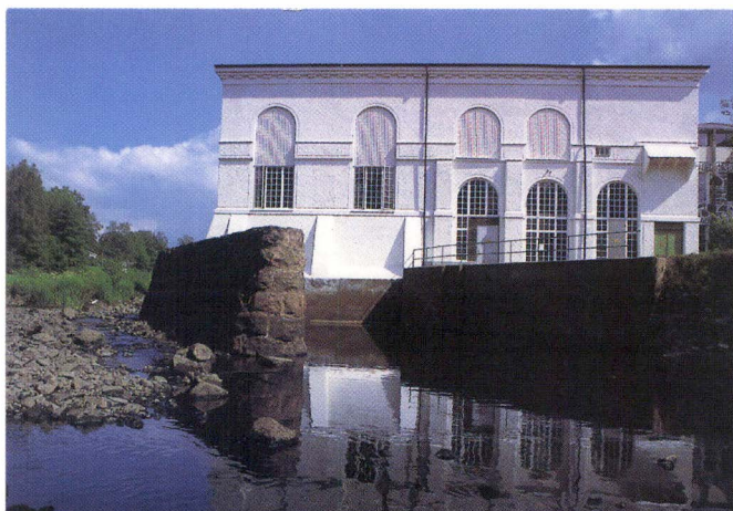
Den nya, nuvarande kraftstationen 1992. Foto: Ove Stanek
