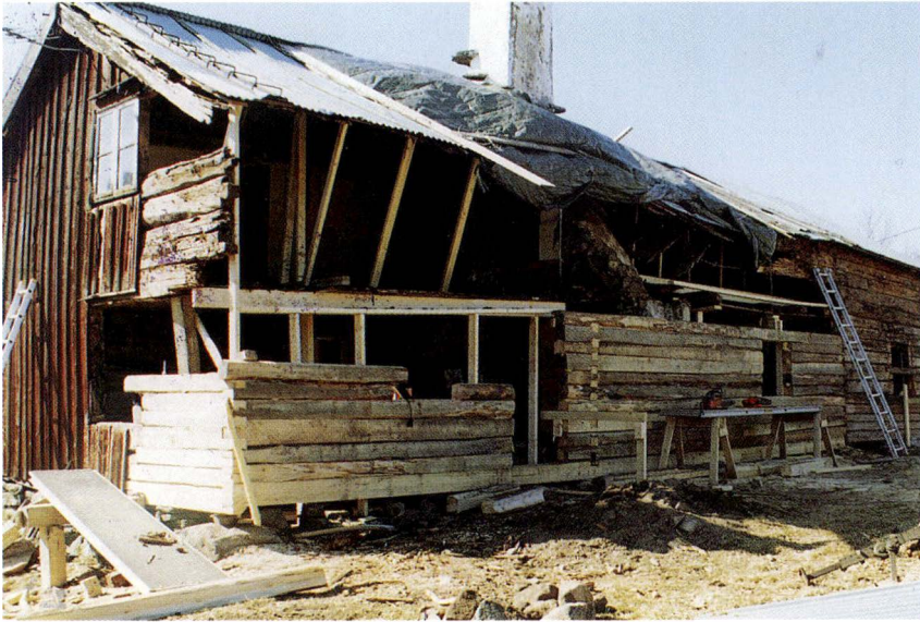
Utbyte av stockar i långloftstugan, Botten.
