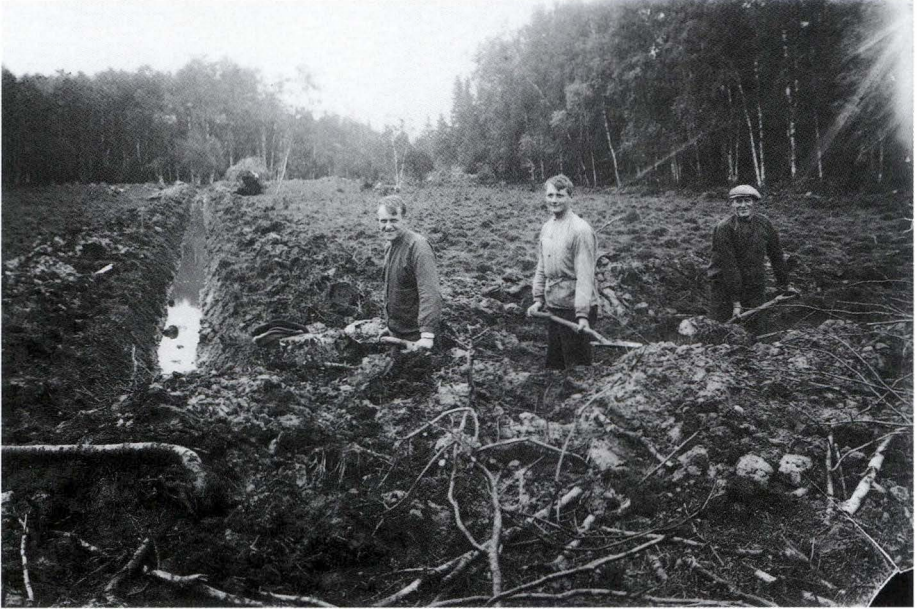
Tre män grävande mösadike. Fredrik Söderbergs glasplåtsamling.
