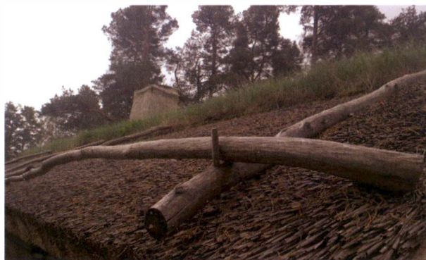
Detalj från taket.
