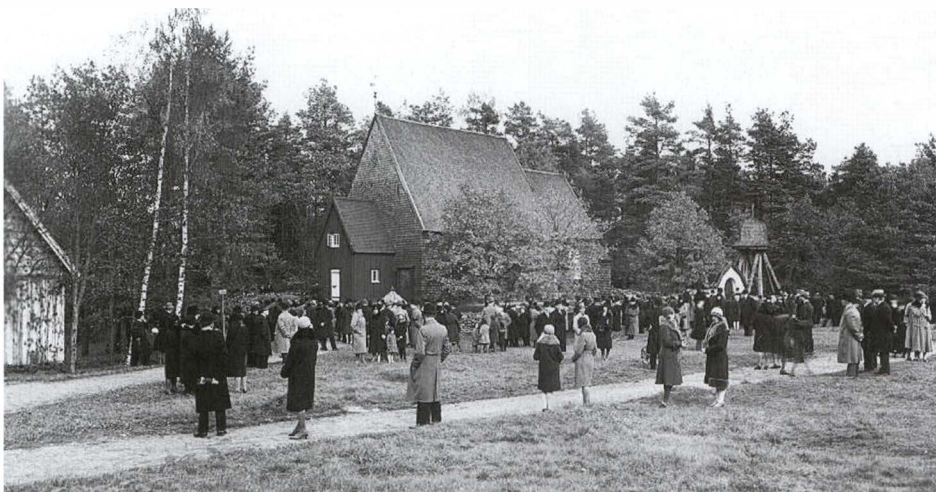
Från återinvigningen av kyrkan 1930. Nytt vapenhus och ny mur runt kyrkan. T.v. redskapsboden, flyttades senare bakom Ramslätt.
