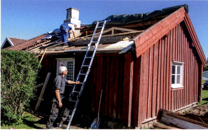
Restaurering av tak och byte av takpannor
