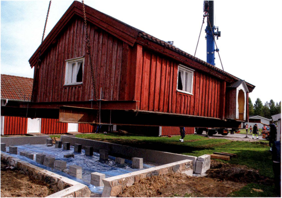
Grälåsastugan placeras på den nyuppförda stenfoten
