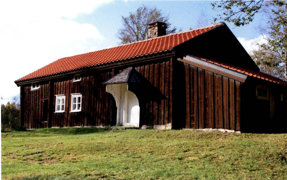
Skärmtaket var tidigare täckt av bräder på hembygdsgården i Hulkeshult. Foto: Carin Nyhage
