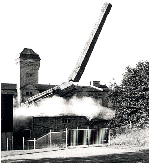
Många av Borås äldre fabriksbyggnader har rivits och då även de för staden kännetecknande höga skorstenarna. Här har Textilmuseets fotograf Torleif Steinsson fångat skorstenen till Borås Spinneri mitt i fallet då den sprängdes 1981. Textilmuseets arkiv.
