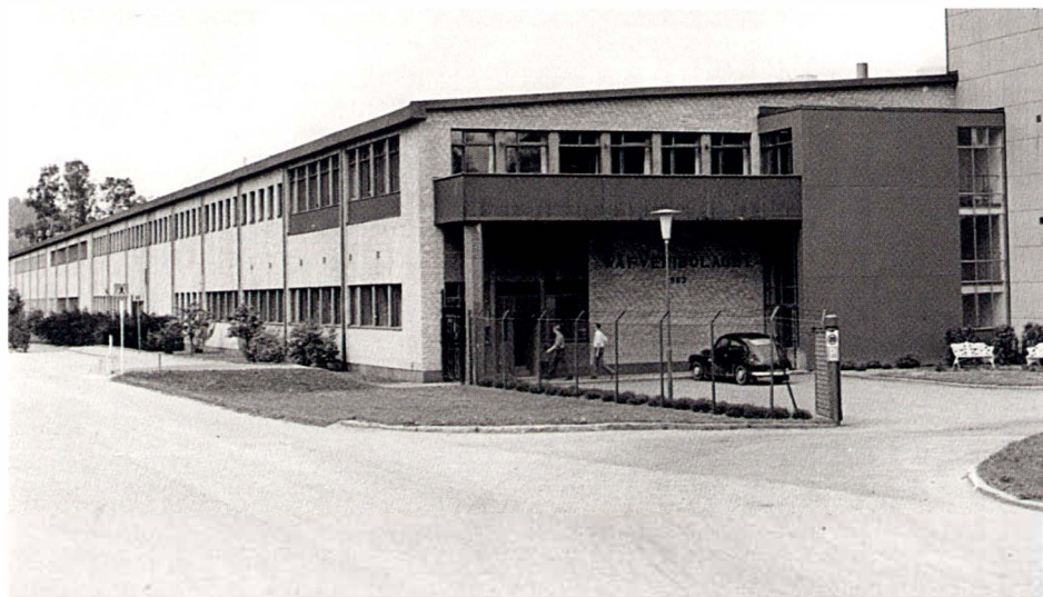
Borås Wärfveris beredningsverk Rydaverket var en stor och toppmodern anläggning som anlades utanför staden i början av 1960-talet. Byggnaden finns kvar än idag. Fotograf: Th. Göransson, 1971. Textilmuseets arkiv.
