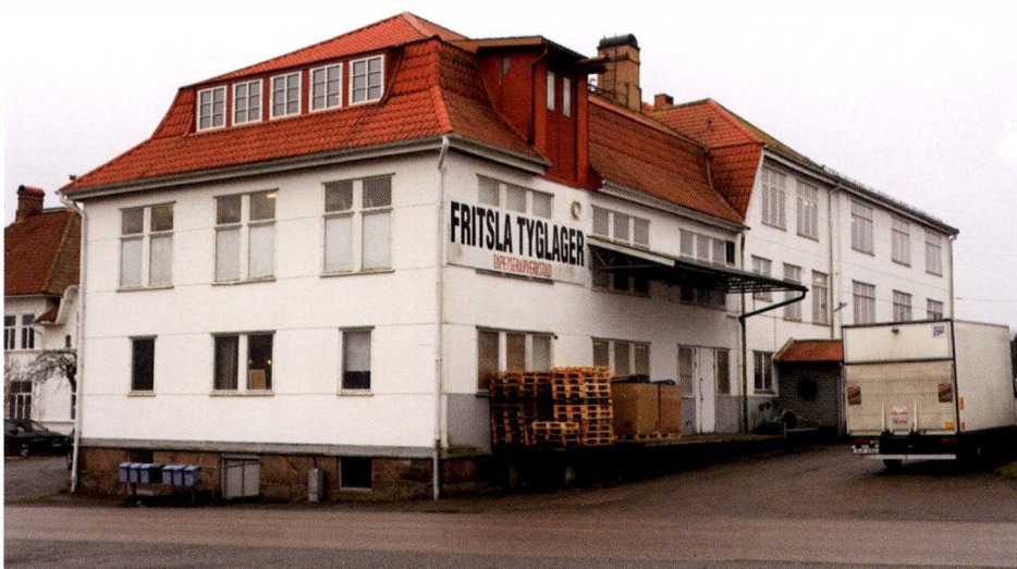
Fritsla Syfabriks före detta fabriksbyggnad på Aratorpsvägen i Fritsla, fotograferad 2023.
